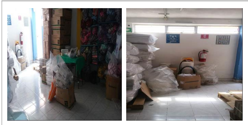
Imagen 8 Acceso al área de inventarios / almacén
